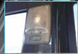
Éclairage à LED
